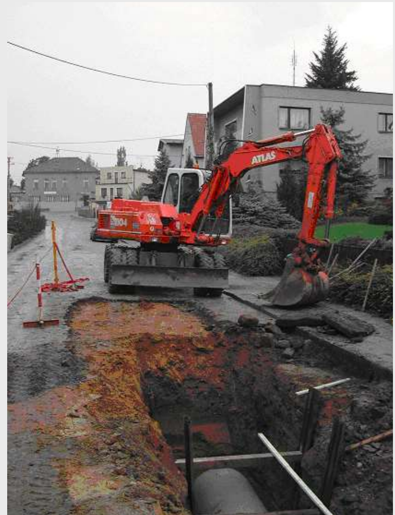
Výkop bez pažení dle Pečená, 2008
