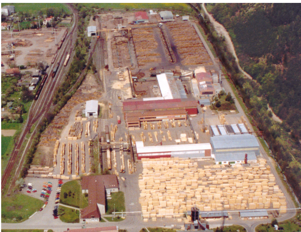
Obrázek 1 – Pilařský závod a jeho tři hlavní části – sklad suroviny (nahore), hala pilnice (ve středu) a sklad řeziva (dole). Pila ve Ptení, objem výroby přibližně 220.000 m 3 kulatiny ročně, dvojsměnný provoz, pouze smrk. (foto Pila Javořice, Ptení)
