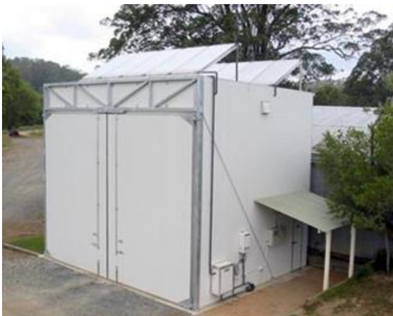
Komorová sušárna řeziva se slunečním kolektorem
