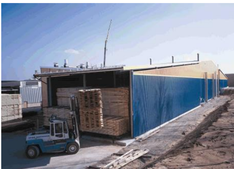
Tunelová sušárna řeziva Valutec
