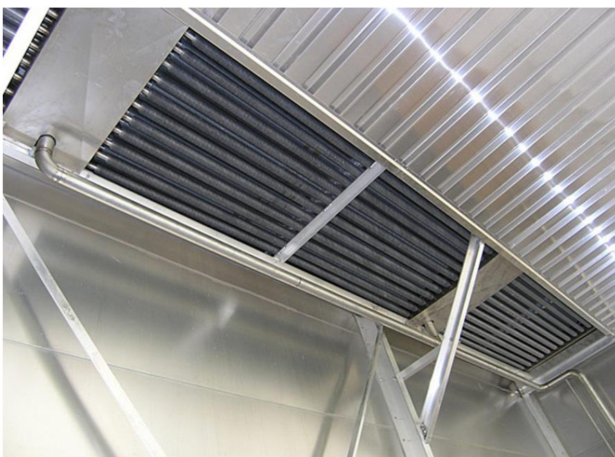
Radiátor s žebry pro účinný ohřev sušícího prostředí uvnitř komory sušárny (Katres)
