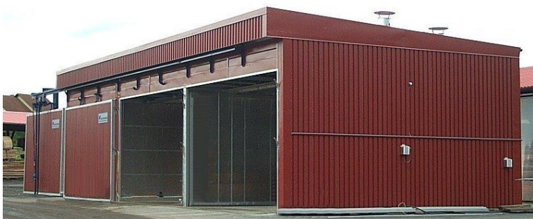
Teplovzdušná komorová sušárna řeziva BES Bollmann
