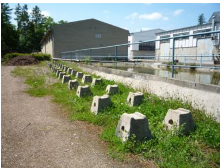
Základ hráně řeziva pro přirozené sušení (betonové podstavce)
