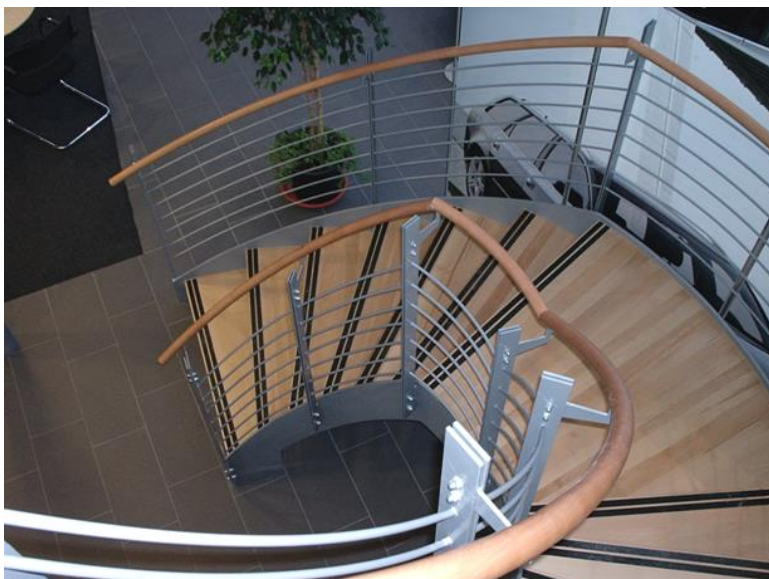
Části zábradlí z trvale tvárného dřeva (ohýbacího) Bendywood Pergola
