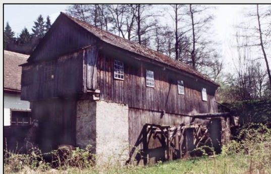
Pohled na objekt
