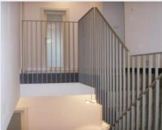
Zábradlí s výplní sloupkovou
