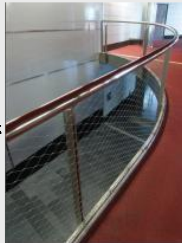
Zábradlí s výplní mřížovou
