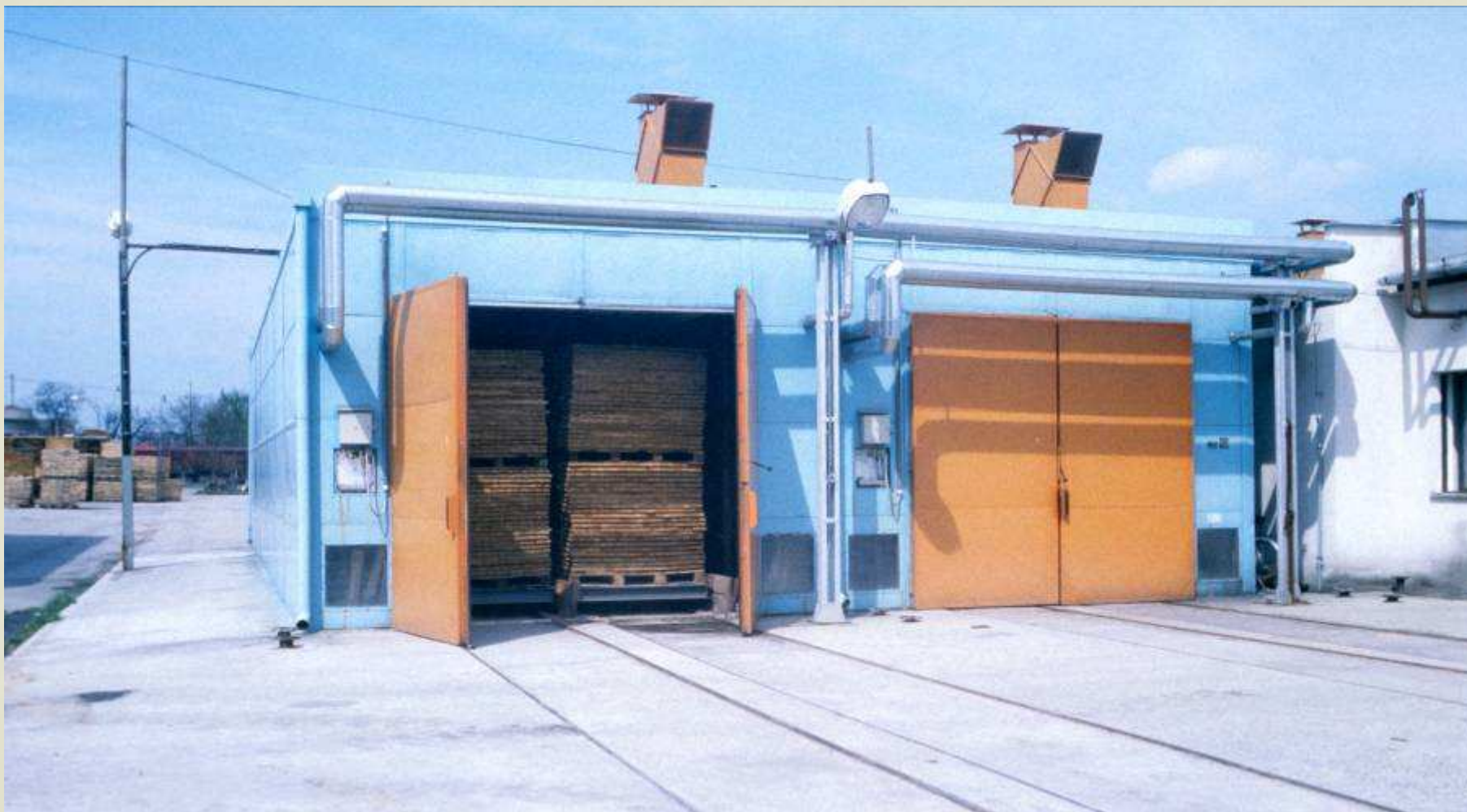
Sušárna řeziva s kolejovými vozíky
