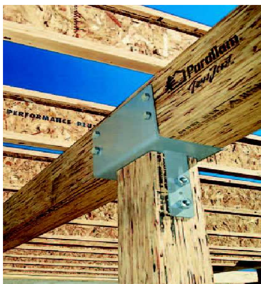
Obr. 13: Konstrukce stavby z Parallamu
