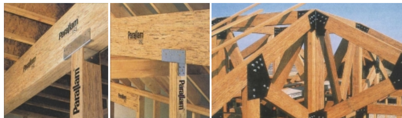
Obr. 1, 2, 3: Použití Parallamu PSL na sloupy, nosníky a vaznice
