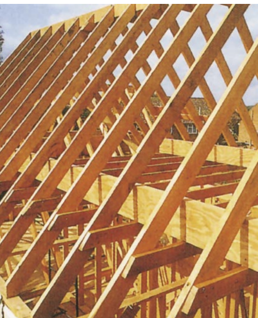
Použití Microllamu LVL na krovy
