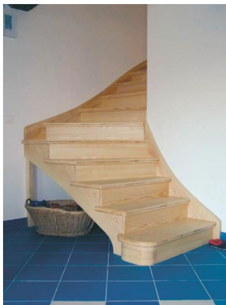
Obr. 3: Použití SWP na schodiště
