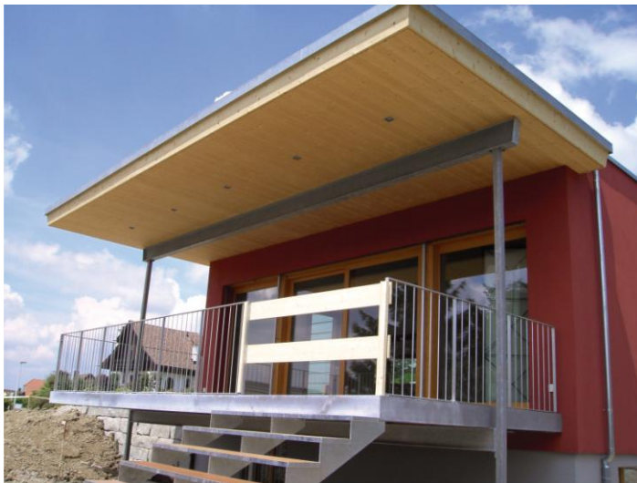
Obr. 2: Použití SWP na přesazenou střechu
