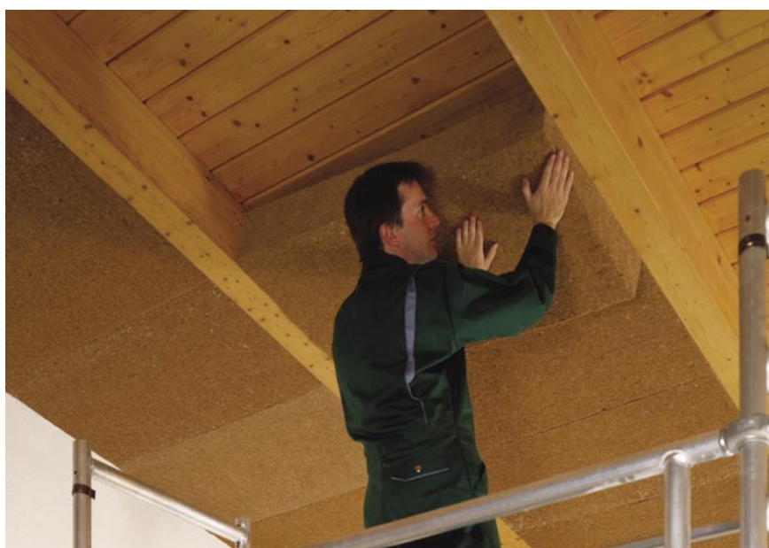
Aplikace vnitřní izolace střechy izolačními dřevovláknitými deskami Homatherm Holzflex
